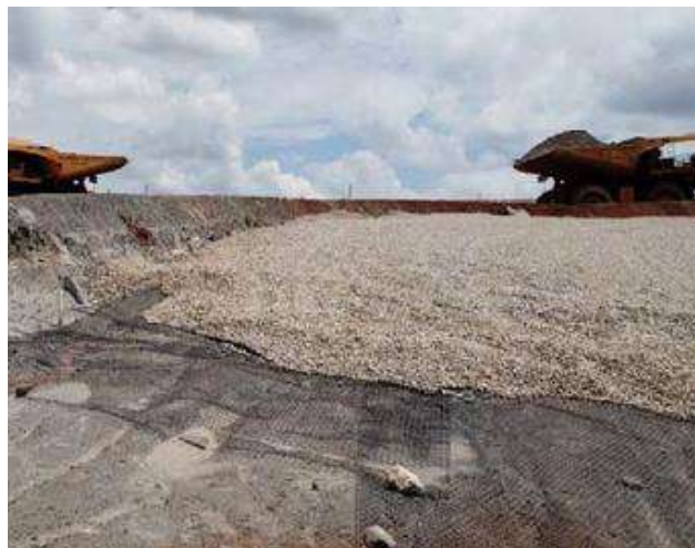
Figura 9. Colocación de capa de rodadura sobre la geomalla.
