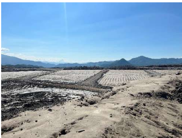
Figura 6. Caminos de acceso al interior del FTFS
