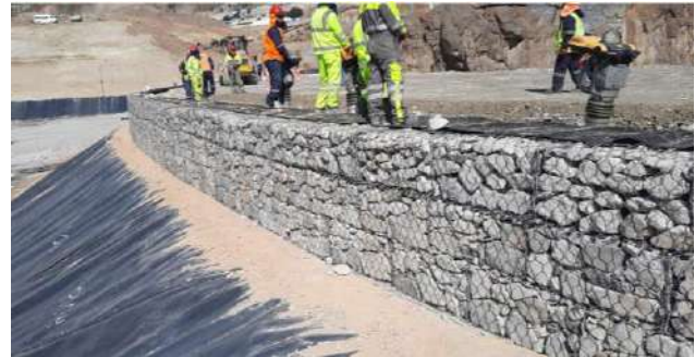
Figura 9. Paramento y compactación con equipo menor.
