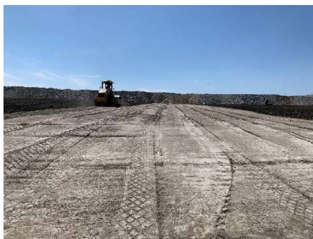
Figura 8. Compactación de plataforma de jales filtrados
