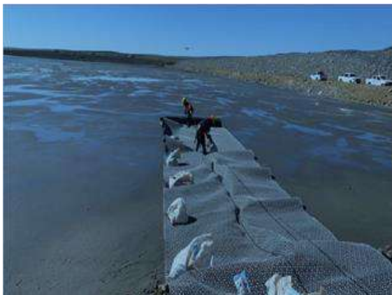
Figura 7. Sección mecánicamente estabilizada con geomalla multiaxial.
