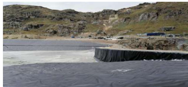
Figura 10. Impermeabilización de la cara húmeda que da hacia el depósito de jales con una geomembrana de HDPE.
