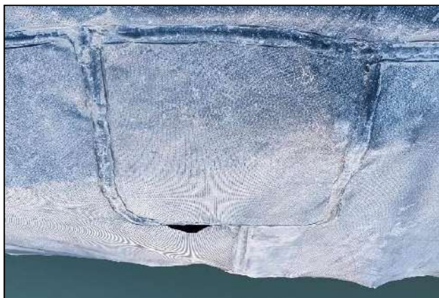
Figura 8. Reparaciones en Vaso 1 de TSF-3.
