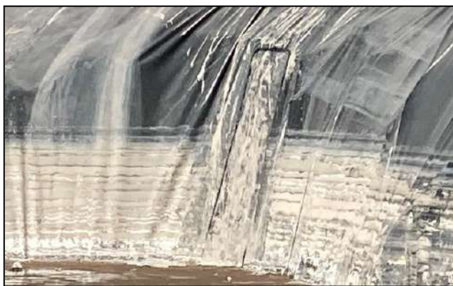
Figura 9. Reparaciones en Vaso 1 de TSF-3.
