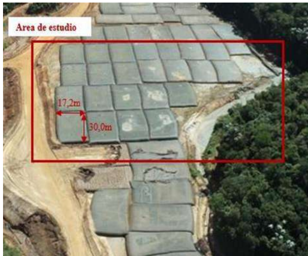
Figura 3. Sistema de tubos geosintéticos implementado
