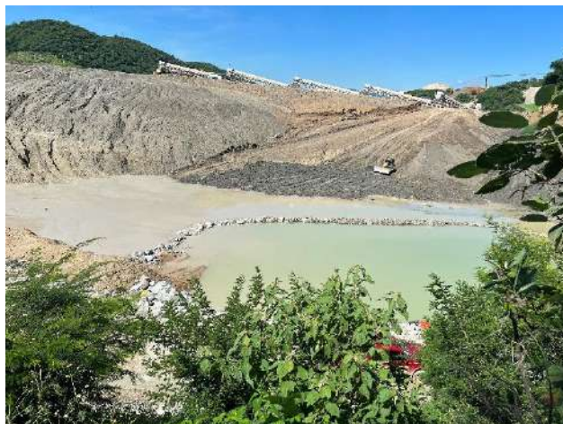
Figura 7. Cárcamo de bombeo temporal en época de lluvias (sección Sur del FTFS)
