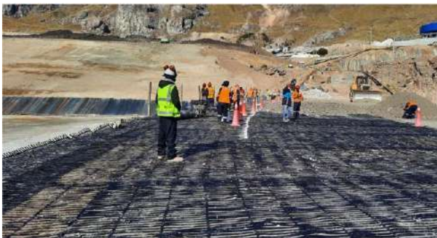
Figura 8. Tendido de geomallas ParaGrid®
