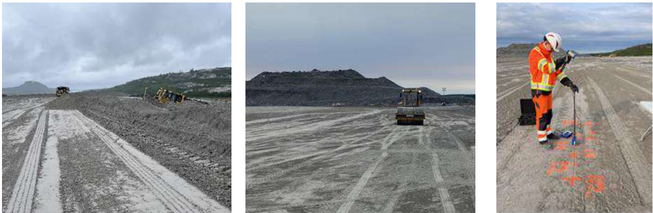
Figura 8. Construcción de las canchas de prueba in-situ (a) deposito y perfilado del material, (b) compactación mediante rodillo vibrante y (c) ejemplo de ensayos de control Panda realizados en sitio por cada pasada, cada capa y cada cancha de prueba
