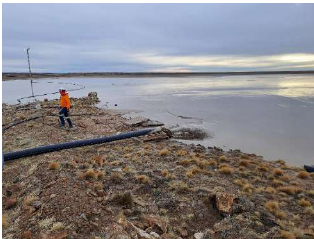
Figura 6. Inspección geotécnica de la instalación de relaves durante la visita del ISTR.
