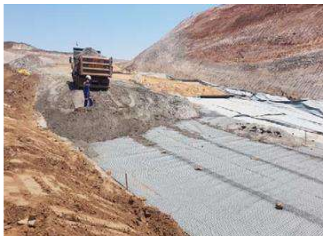
Figura 10. Colocación de material esteril sobre la geomalla.
